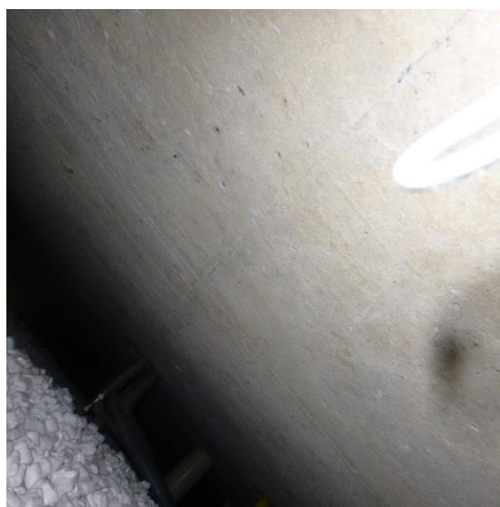
Onderzijde begane grondvloer.
