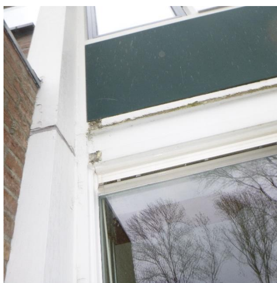
Kleine schade zijn betonwerk ter plaatse van bevestigingspunten
