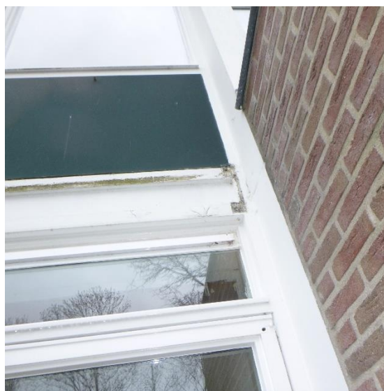
Kleine schade zijn betonwerk ter plaatse van bevestigingspunten
