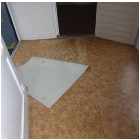
Vloer te plaatsen van tussenbouw.
