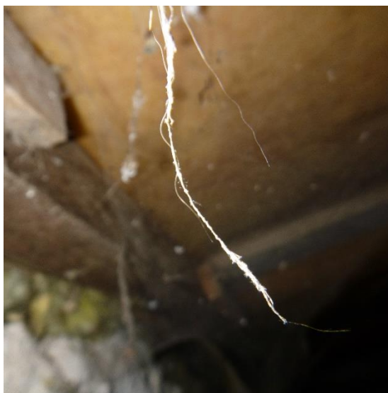
Onderzijdevloer tussen bouw.
