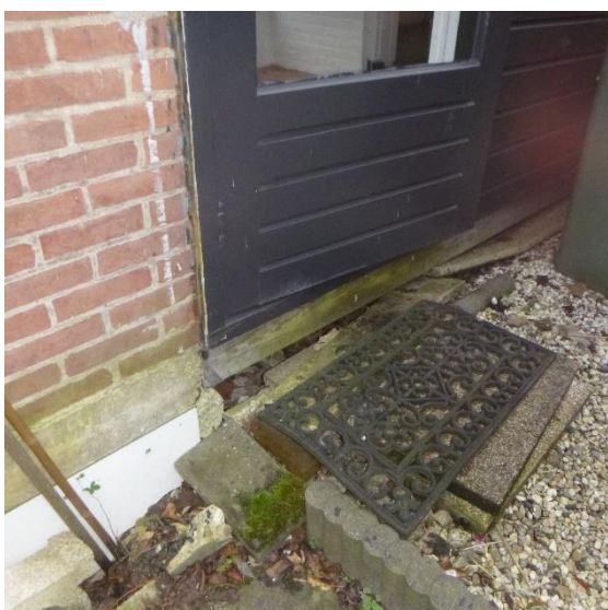
Bestrating/grondslag fors gezakt.
